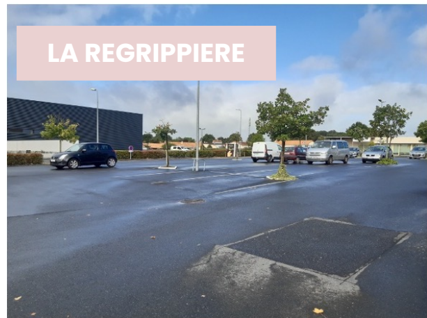
réhabilitation d'un parking de 1300 m 2
