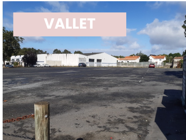
réhabilitation d'un parking de 4900 m 2
